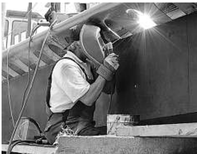
Knapper Zeitplan: Bis Ende August soll die LS Stäfa fertig umgebaut sein.
