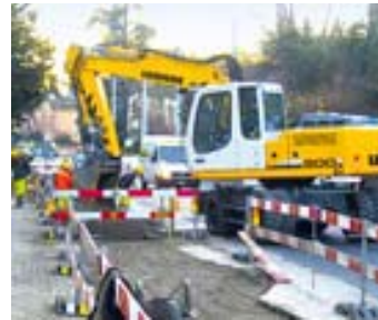
Arbeiten entlang der Tramgleise: Seestrasse.
